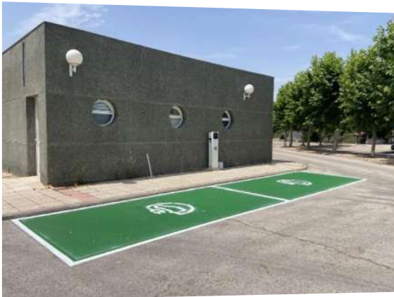
Cargador eléctrico en Colisée Villanueva del Pardillo.
